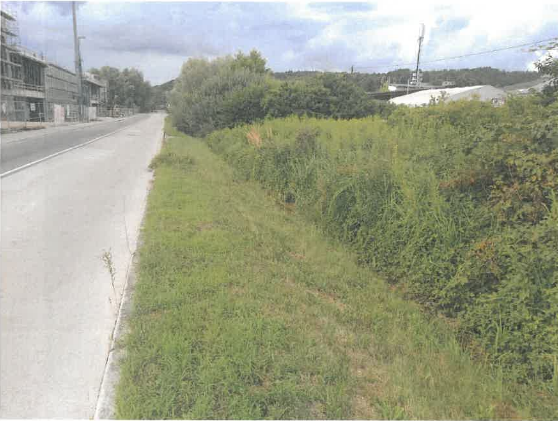
Slika 3: Odvodni zemeljski jarek na levi strani proge ob Cvetkovi ulici (pogled v smeri Ljubljane)
