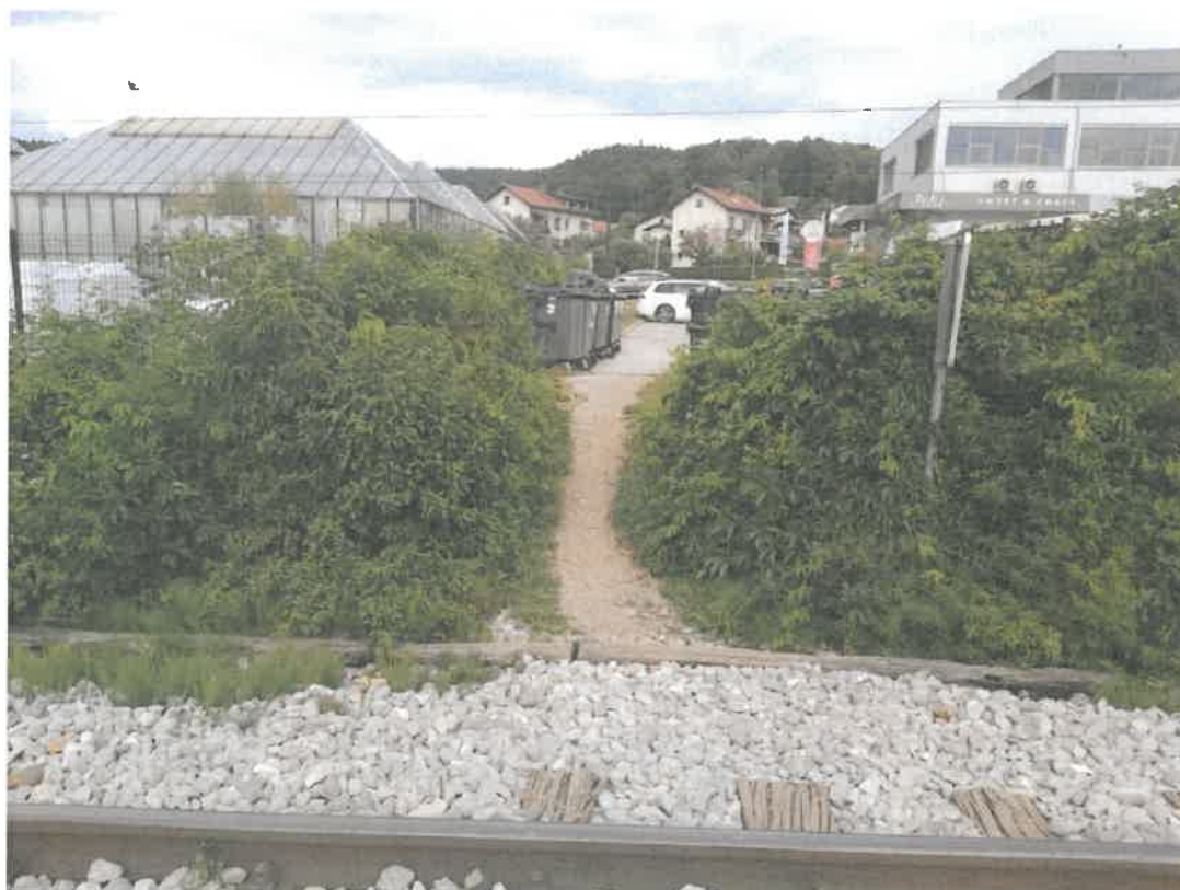
Slika 5: Nelegalen prehod preko proge približno v km 147+180 – pogled v smeri Dolenjske ceste Projektna naloga za izdelavo izvedbenega načrta za gradnjo novega železniškega postajališča Ljubljana Rudnik stran 48
