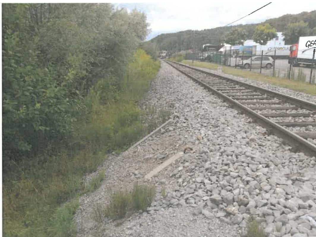
Slika 9: Širše območje predvidenega novega postajališča Ljubljana Rudnik (pogled v smeri Ljubljane) – opuščeni AB okvir za razklad kamnitih agregatov v približnem km 147+370
